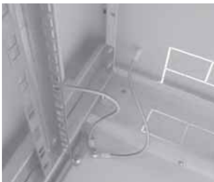
Detail vodivého pospojování
